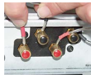
Anbringen der Anschlusskabel
